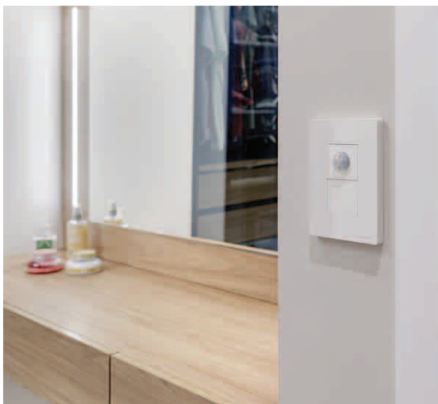
Outro ângulo da sala de jantar, integrada à varanda e com caixas de teto. Nos detalhes, keypads com sensores de movimento, temperatura e luminosidade acionam rotinas de automação na suíte e banheiros.
